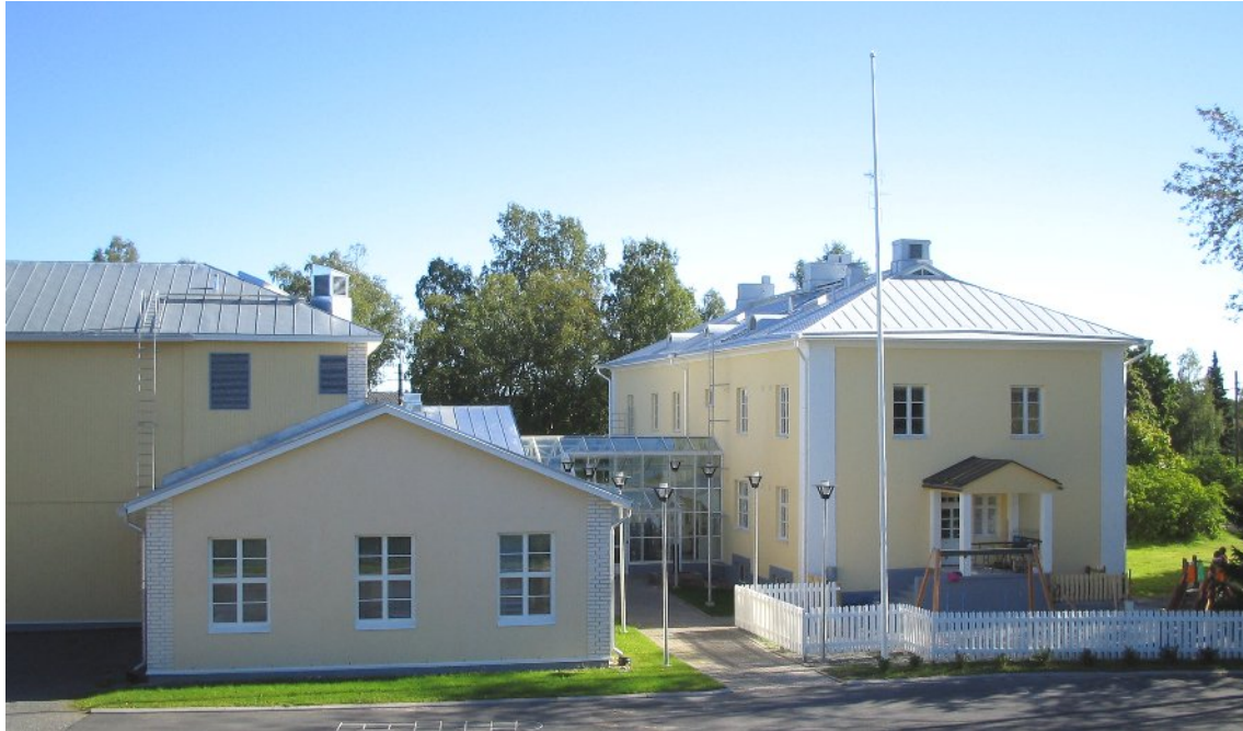
Kuva Kodisjoen koulun uudisrakennuksesta ja vanhasta peruskorjatusta koulusta.
